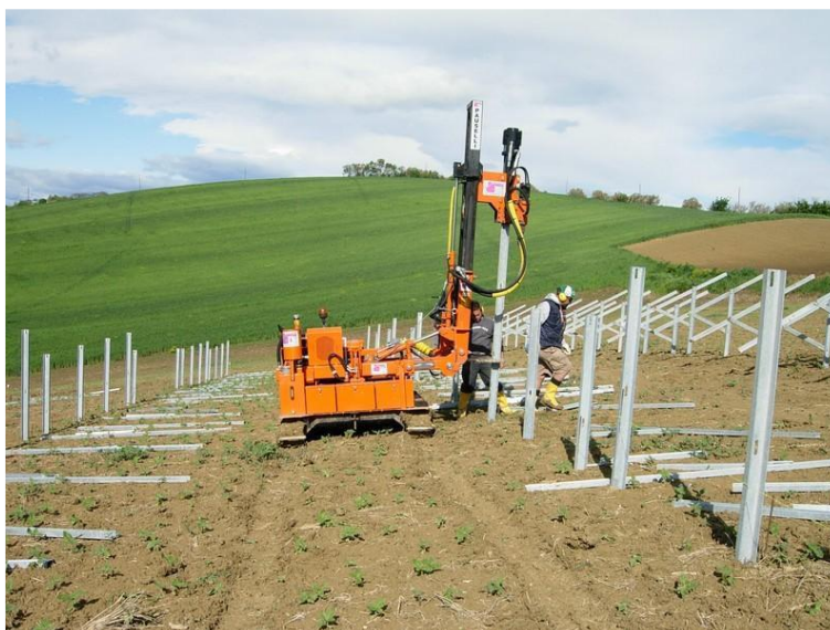
Figura 3.10 – Perfuração das estacas de suporte
