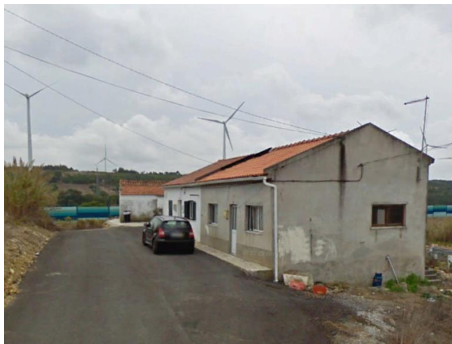
Figura 4.58 – Conjunto habitacional mais próximo da área de estudo (610 m)
