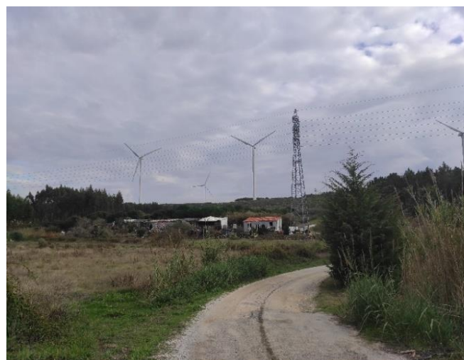
Figura 4.57 – Anexo junto ao caminho de acesso ao Parque Eólico, desde o centro de Serra d'El Rei
