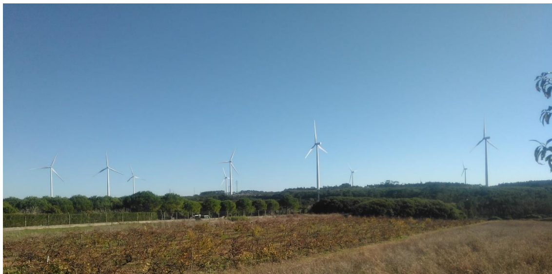
Figura 6.1 – Vista para a área de implantação da central a partir do limite sudoeste da localidade de Serra d'El Rei (Vista N-S)
