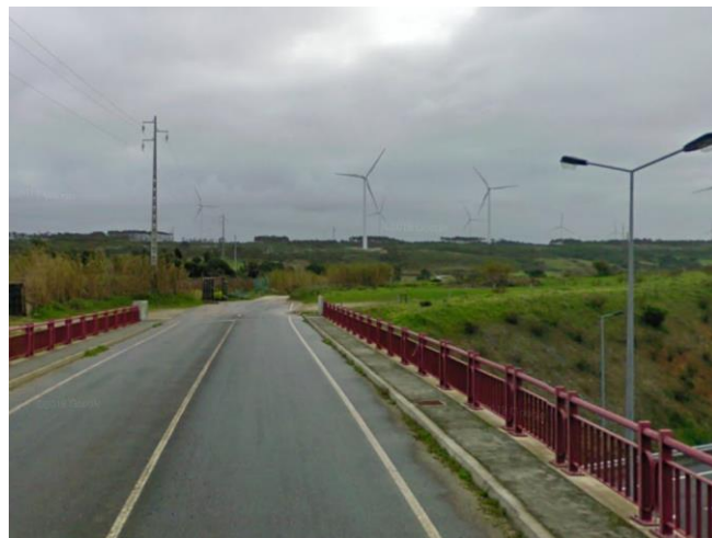
Figura 4.59 – Passagem superior por onde é possível aceder ao parque eólico desde o extremo nascente de Serra d'El Rei
